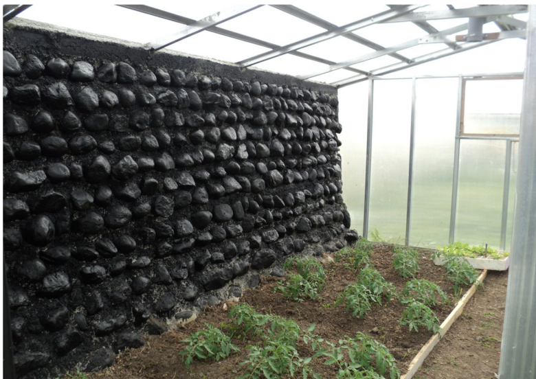
Innovación consistente en el pintado de muro para lograr aumento de temperatura al interior del invernadero.
